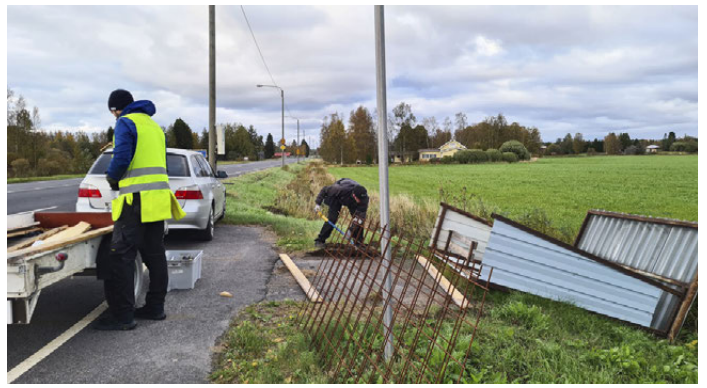
Parhalahden vanhat huonokuntoiset bussikatokset kerättiin pois uusien tieltä. Tässä aloitellaan pohjalaatan muotin tekoa.
