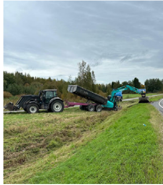
Pohjatyöiden tekoa katokselle numero neljä.
